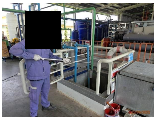
รูปที่ 15 การเก็บตัวอย่างน้ำเสียจากถังบำบัดน้ำเสีย แบบสำเร็จรูป
