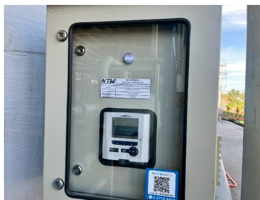
รูปที่ 20 เครื่องตรวจวัด EC/TDS Online (Electric Conductivity/ Total Dissolve Solid)
